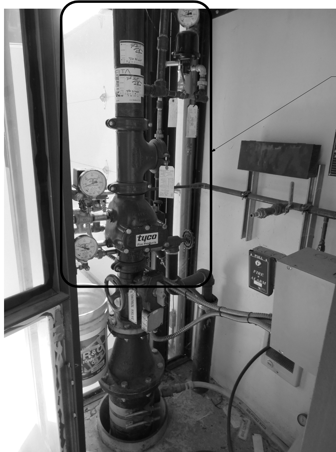
4 FIRE RISER DETAIL N.T.S.
